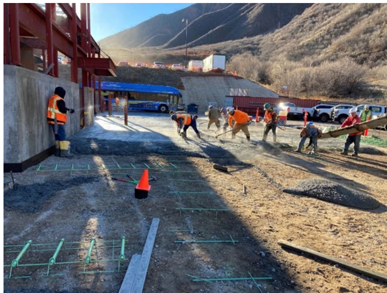
Concrete pour at the GMF
